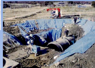
県広域水道φ2400の修繕状況
