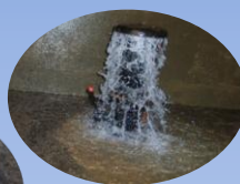
空気弁の破損
