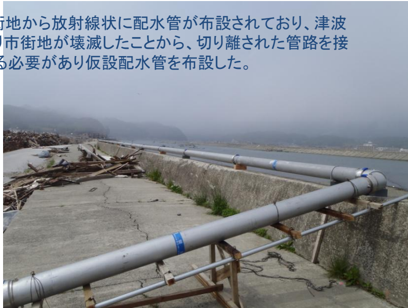
仮設配水管布設状況
