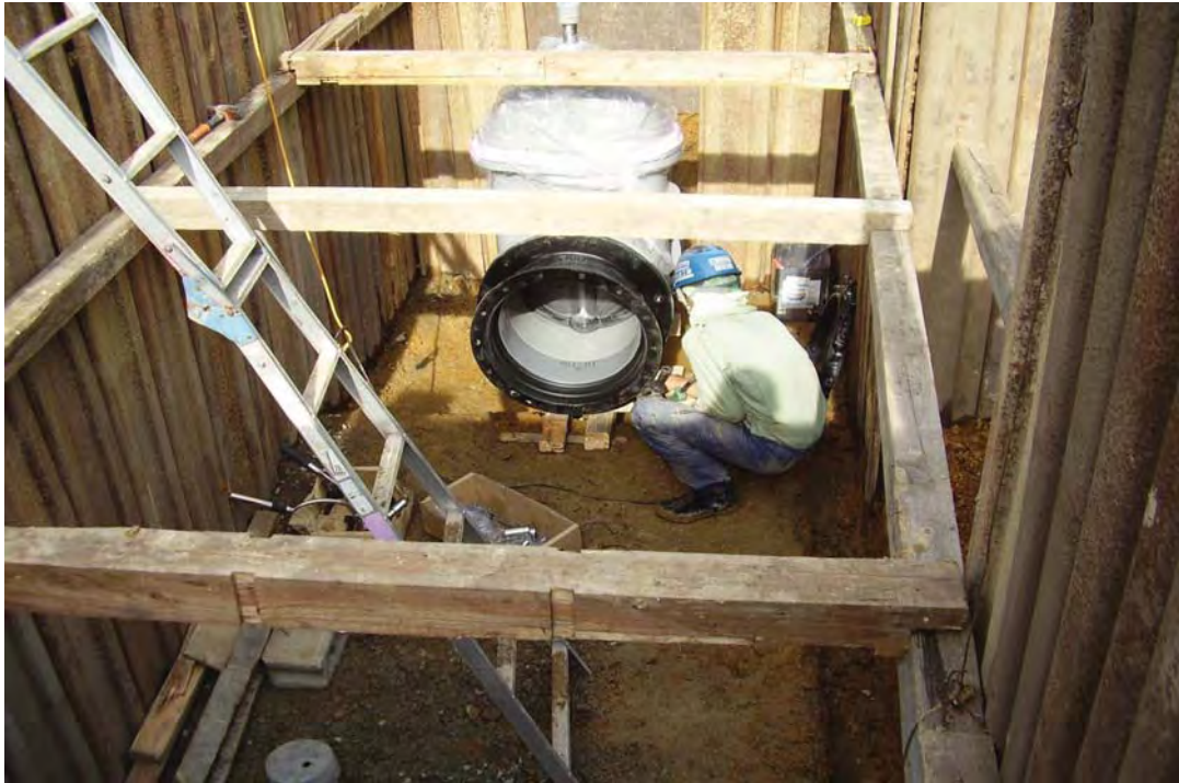
終点部配管状況(6月15日 500仕切弁取り付け)
