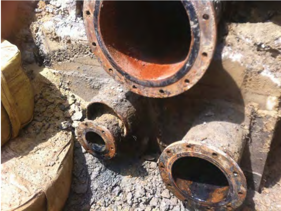
推進刃口(7月2日 コンクリート取り壊し後)
