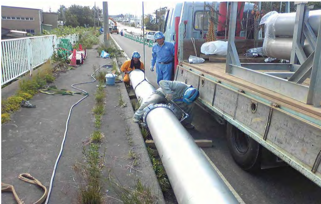
跨線橋付近仮設配管工事(6月15日 SUS400)
