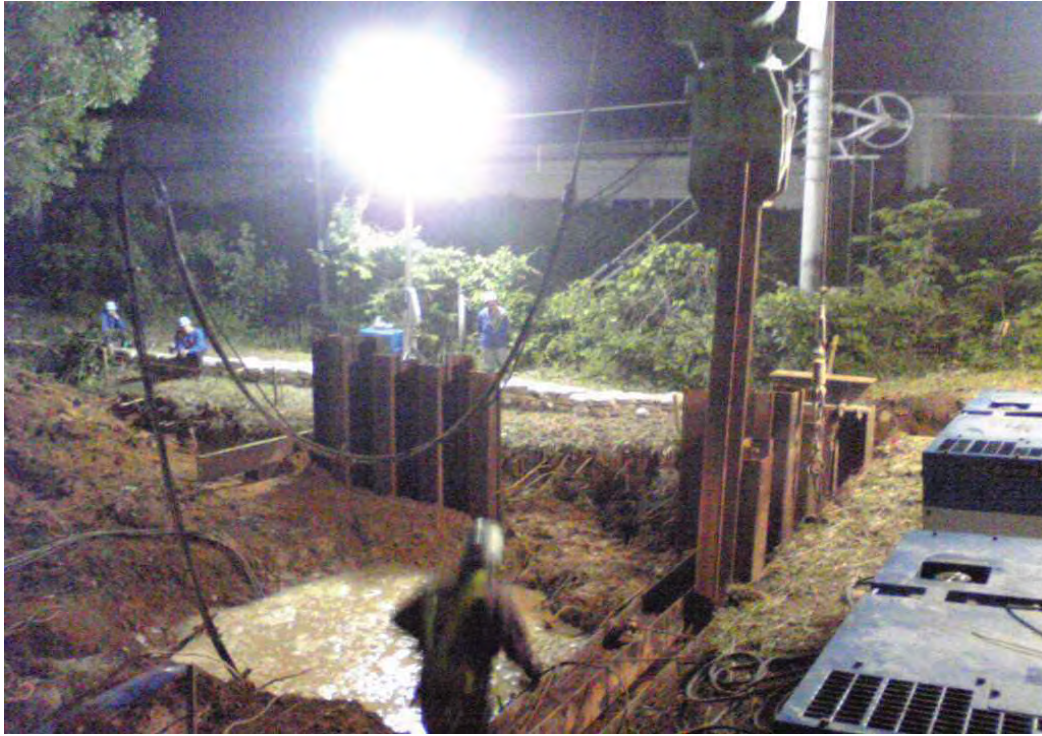
鋼矢板打ち込み(6月12日22時)
