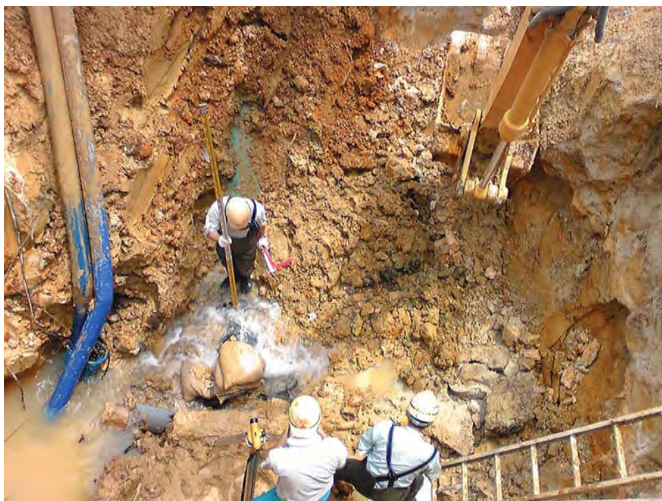
カバージョイント制作の寸法取り(6月13日13時)
