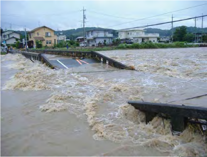
厚狭川横断主要送配水管断裂
