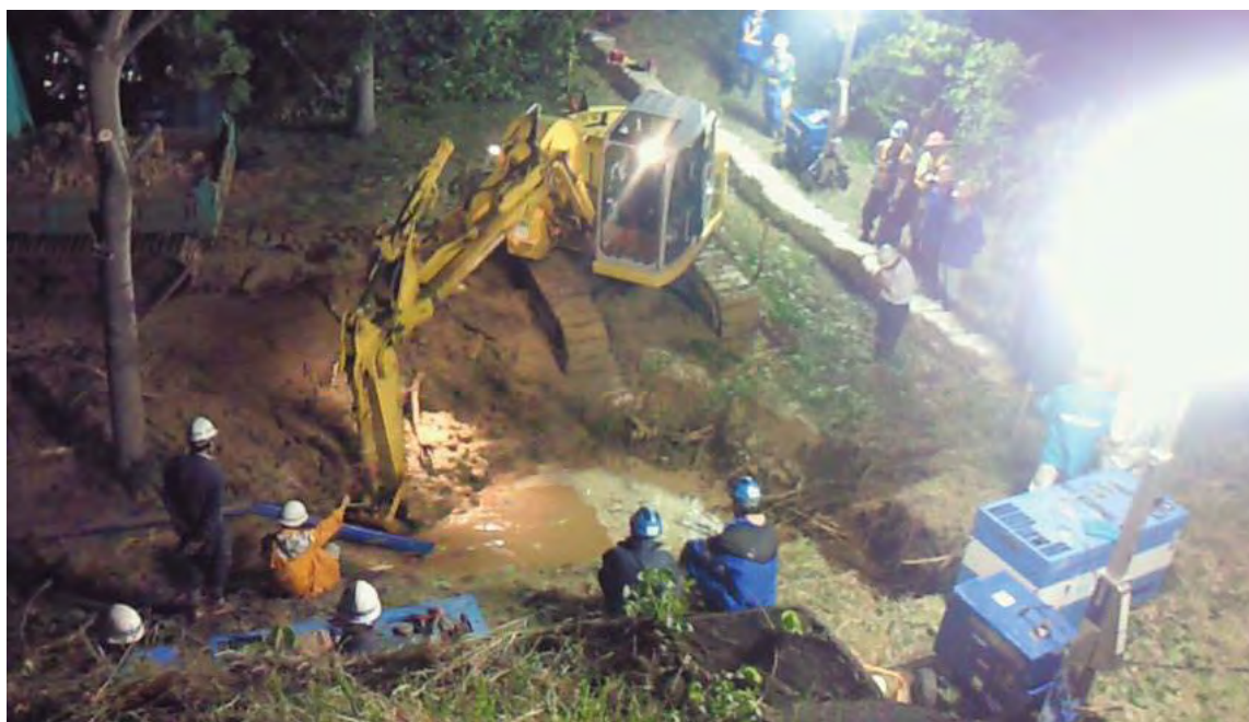
断水工事による掘削開始(6月11日)
