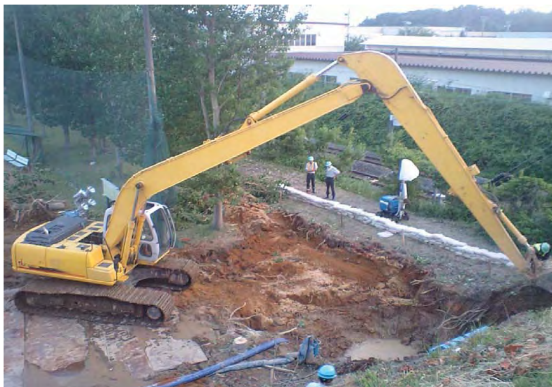
ロングアームのバックホーによる掘削(6月12日19時)
