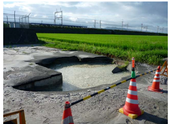
漏水による陥没状況
