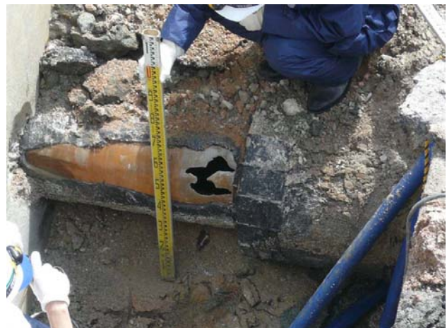
漏水による陥没状況
