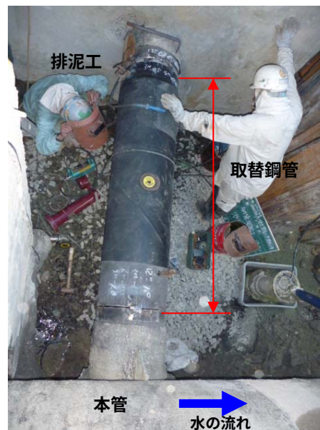
応急復旧工事
