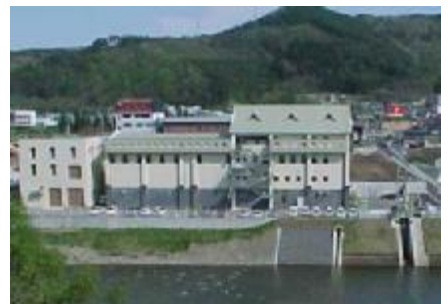
二戸市浄水場
