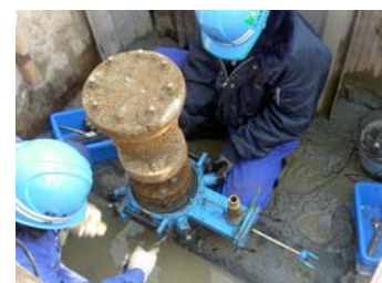
補修弁取替工法
