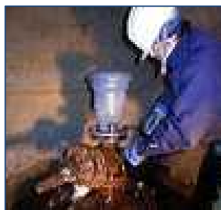
管路点検（幹線弁室）
