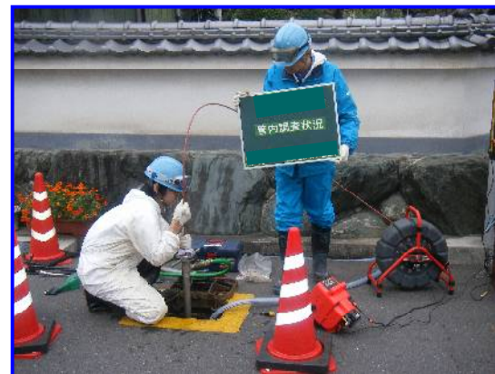
管内調査(不断水管内カメラ調査)
