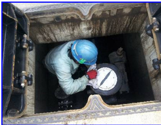
付属物調査(弁栓類点検)
