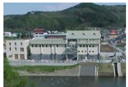
二戸市浄水場
