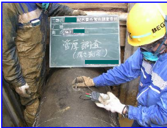
管体調査(超音波管厚測定)
