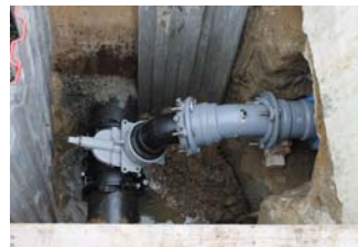
耐震形ヤノ T 字管 T 型
