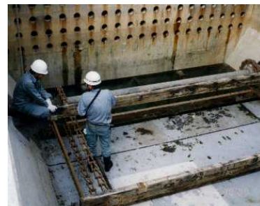
沈澱池機械の点検調査
