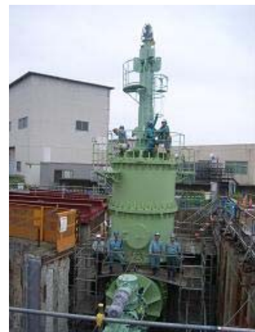
インサートینگバタフライ弁設置工事
