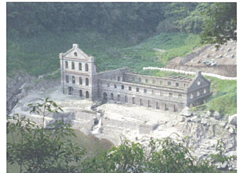
旧曾木発電所遺構
