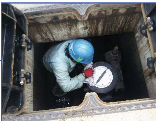
付属物調査(弁栓類点検)
