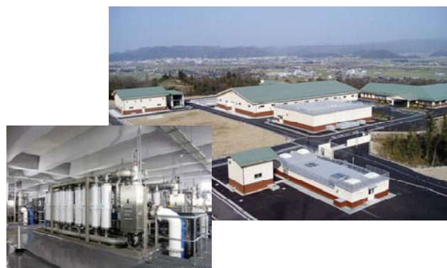
DB方式により日本最大級(80,000 m 3 /日)の膜ろ過設備を納入(鳥取市江山浄水場様)
