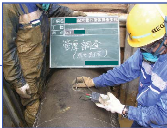
管体調査(超音波管厚測定)
