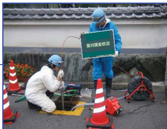
管内調査(不断水管内カメラ調査)
