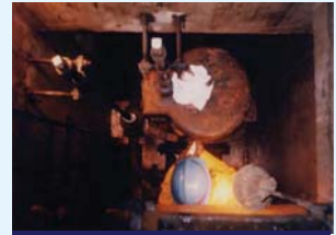
バルブの点検・清掃
