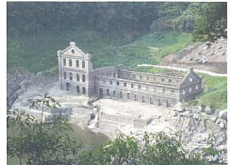
旧曾木発電所遺構
