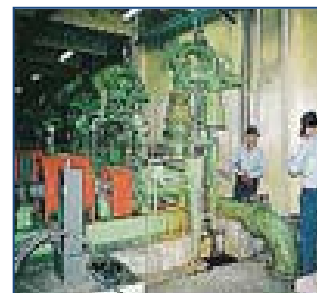
巡視点検（ポンプ場）
