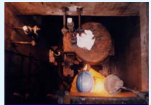
バルブの点検・清掃
