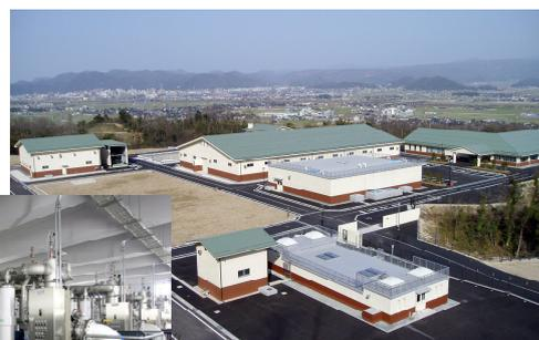
DB方式により日本最大級(80,000 m<sup>3</sup>/日)の膜ろ過設備を納入(鳥取市江山浄水場様)
