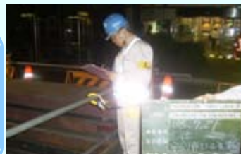
夜間工事パトロール
