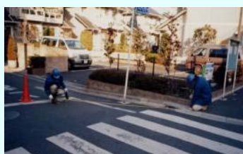
現地調査、路線測量
