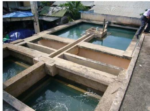
写真 15 沈澱池、ろ過池
