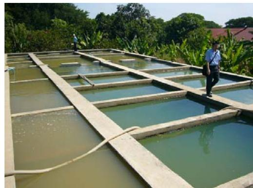
写真 17 沈殿池 (左)、ろ過池 (右)
