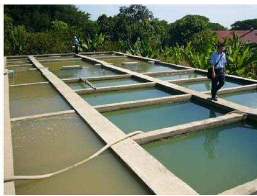
写真 17 沈殿池 (左)、ろ過池 (右)
