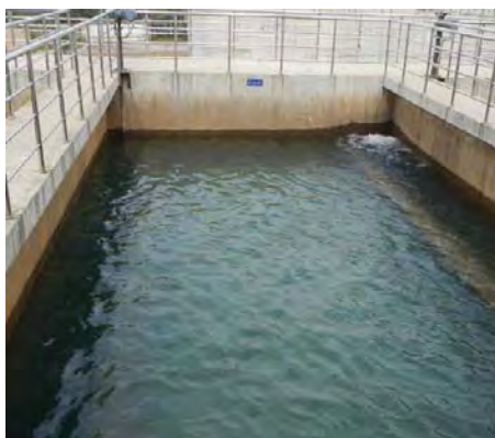
写真 2 3 フエ省 Quang Te 浄水場ろ過池
