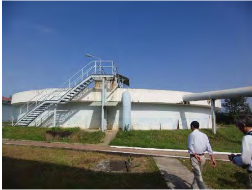
写真 1 3 ダナン市 San Bay 浄水場見学
