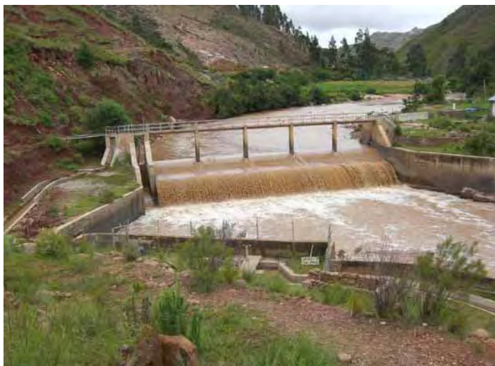
取水堰 ササンタ地区貯水池予定地より下流へ約5kmの地点に位置し、現浄水施設(エルロジョ浄水場)への取水堰として使用されている。
