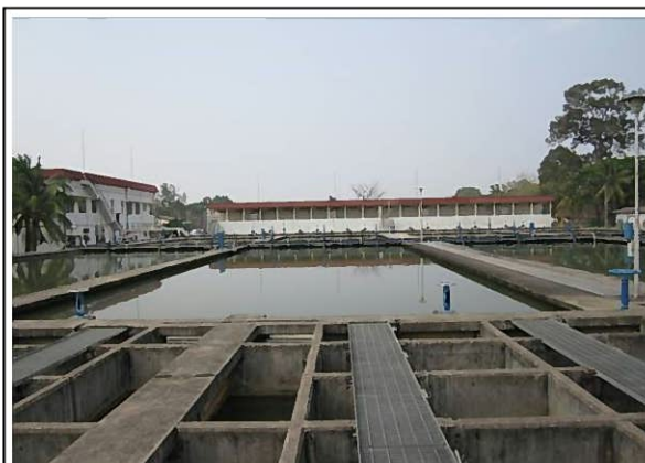
首都ビエンチャン水道局 チナイモ浄水場設備風景（フロキュレータ側より） 水質管理を基に、浄水処理管理を実施
