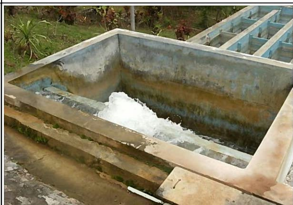
ルアンパバン県水道局 プープン浄水場（水源は湧水、緩速ろ過の生物膜の形成が未熟であるが、水質管理により浄水処理の適正を確認している）
