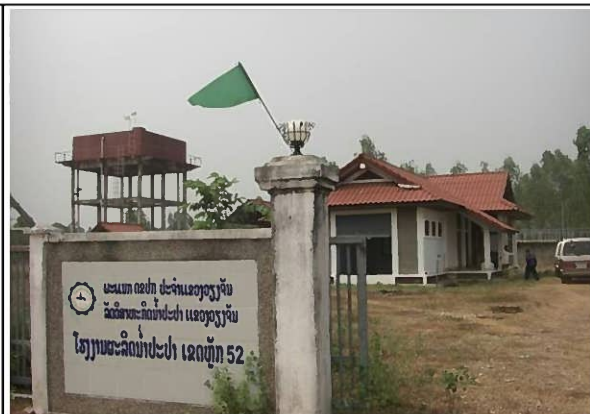
ビエンチャン県水道局ランチ 52KM浄水場（薬品沈殿・急速ろ過による浄水処理）
