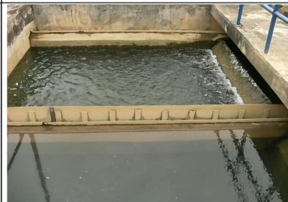
ルアンパバン県水道局 パーナム浄水場ろ過池（水源はナムクァン川表流水、沈殿が不十分でフロクの浮遊が視認）
