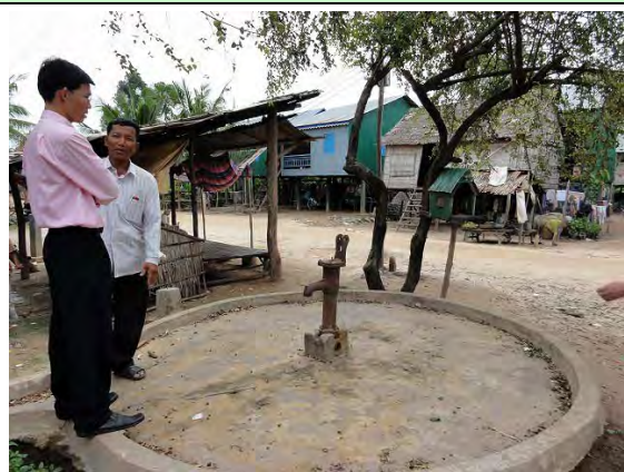
ヒ素汚により廃棄された井戸 (Preaek Dach コミューン)
