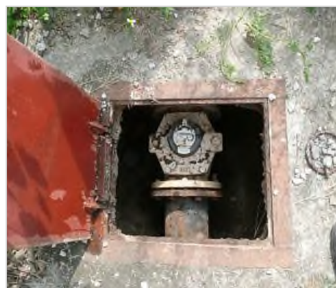
図 4-27 水道施設（水道メーター）
