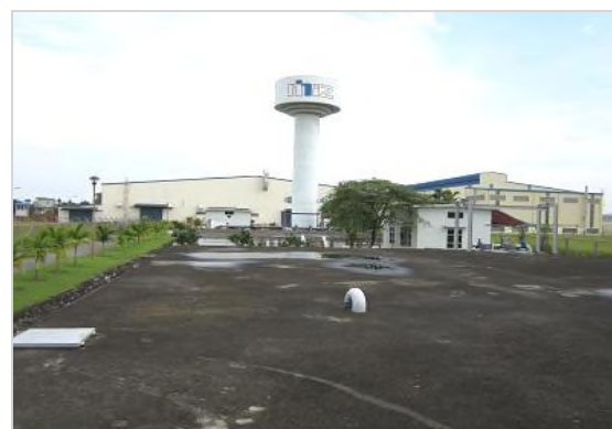
図 4-4 水道施設の概況（高架水槽）
