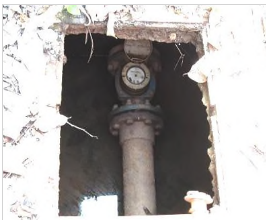
図 4-16 水道施設 (水道メーター)
