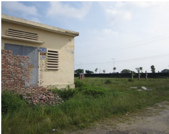
図 4-14 水道施設 (メーター室)
