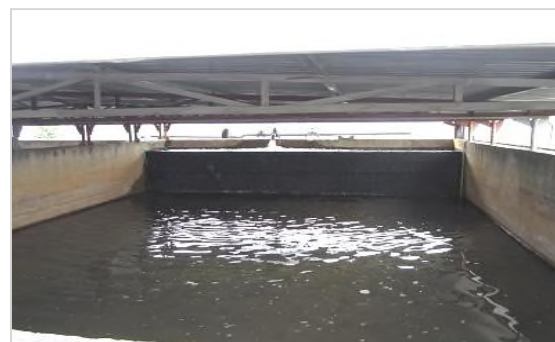
図 4-5 水道施設の概況（砂ろ過）
