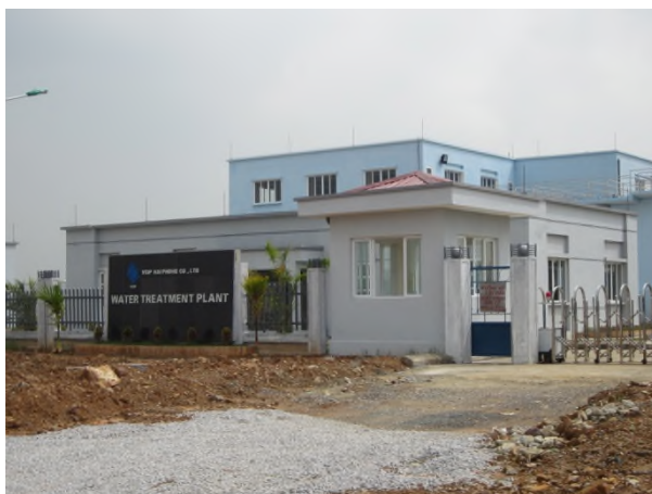
図 4-20 工業団地内浄水施設
