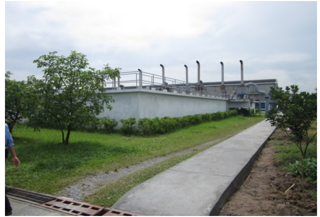
図 4-7 水道施設の概況（浄水池）
