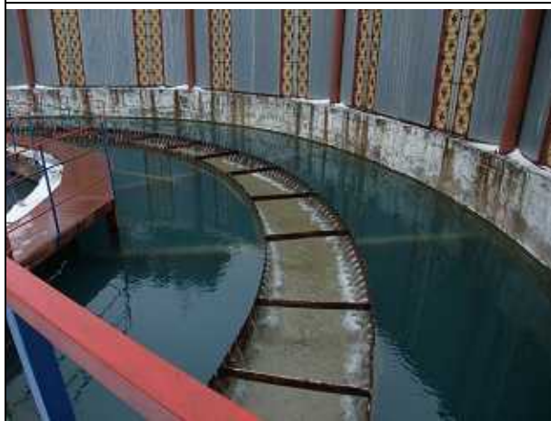
高速凝集沈殿池内部
