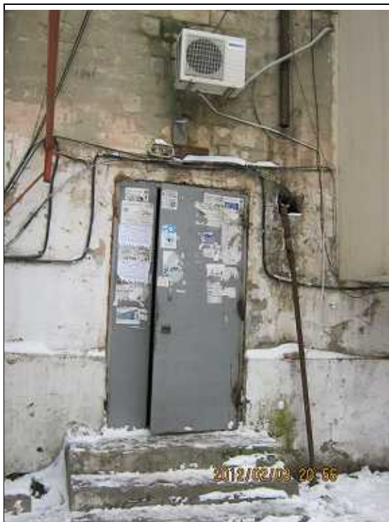
水質試験室入り口（古いビルの 1 階）
