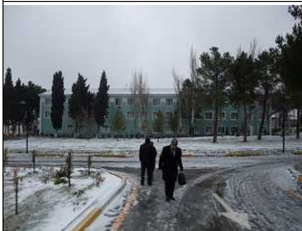
ジェイランバタン浄水場管理棟
