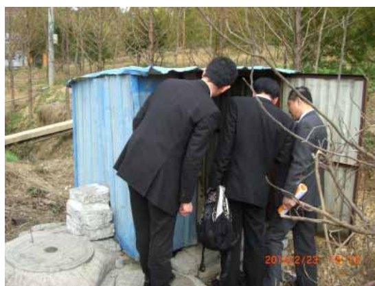
残圧不足地域のラインポンプの視察
