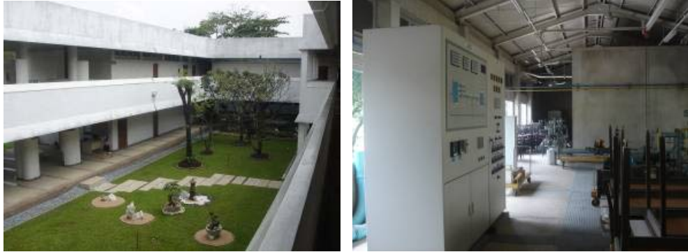
図 6-4 (左)旧 CTC 研修棟中庭、(右) 旧 CTC 研修棟配水コントロール制御システム
