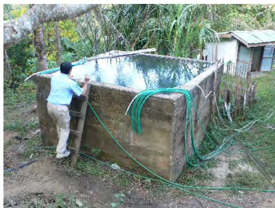
既存の貯水池と各戸へ引込むパイプ
