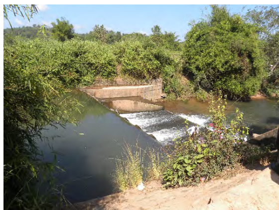
ピアン川 灌漑用取水堰 (取水・浄水装置設置予定地)
