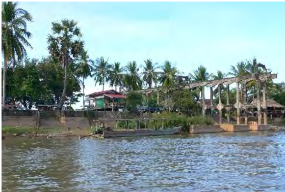
ドンデット地区 取水・浄水装置設置予定地 (フランス統治時代建設の河川港施設)
