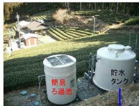
簡易ろ過池に沢水が入り、砂・砂利でろ過した水を貯水タンクへ貯めて給水します。
