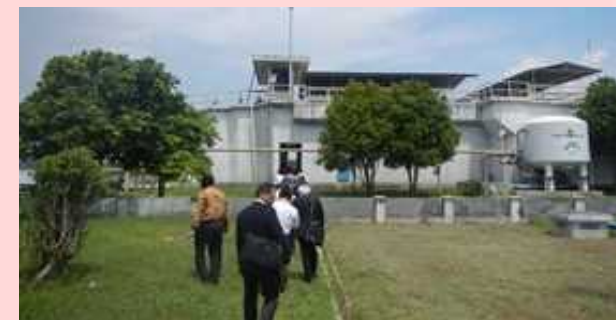
既設浄水場の調査
