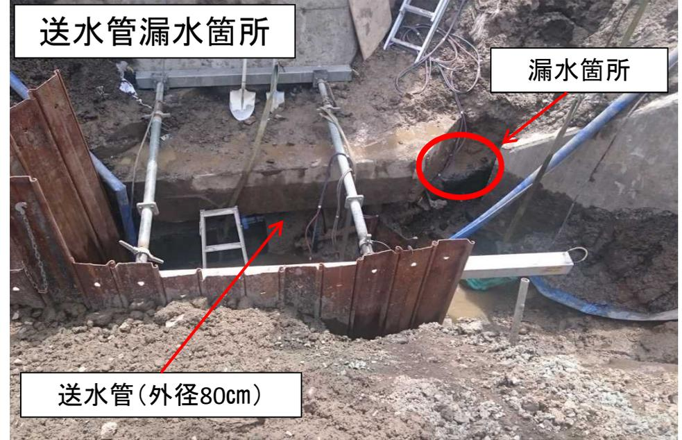
送水管漏水状況
