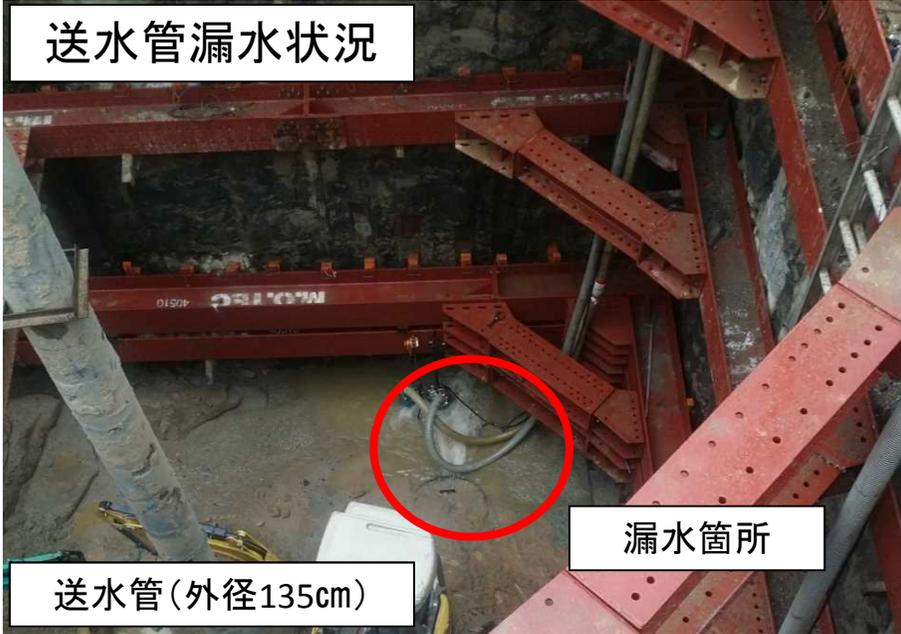
送水管漏水箇所
