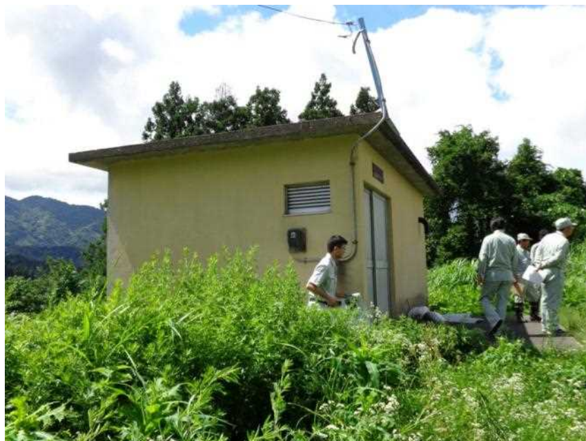
あらやま 新山簡易水道配水池
