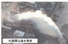
大規模な漏水事故
