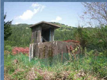
小規模水道の浄水場(施工前)
