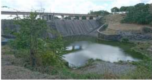
No.7 Cacoyoguinダム 1957年に建設されたコンクリートダム。Alcides Pino浄水場へ導水している。
