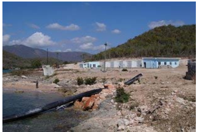
海水淡水化プラント(建設中)
