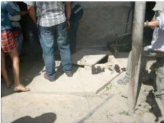
写真1 家庭の地下配水タンク
