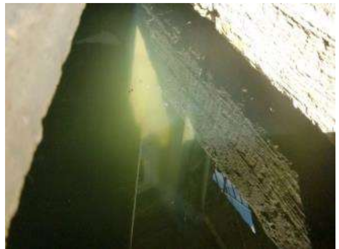
写真2 配水タンクの中の水
