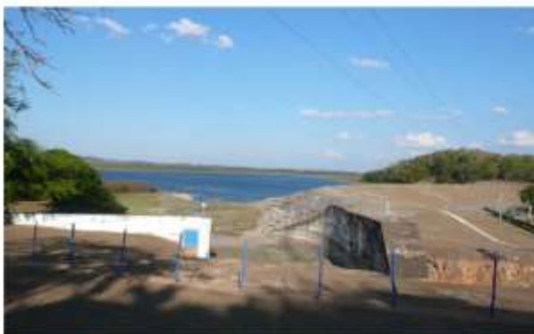
No.11 Guiraboダム 1969年に建設されたアースフィルダム。41%の貯水量しか水がない。Pedernales浄水場へ導水をしている。
