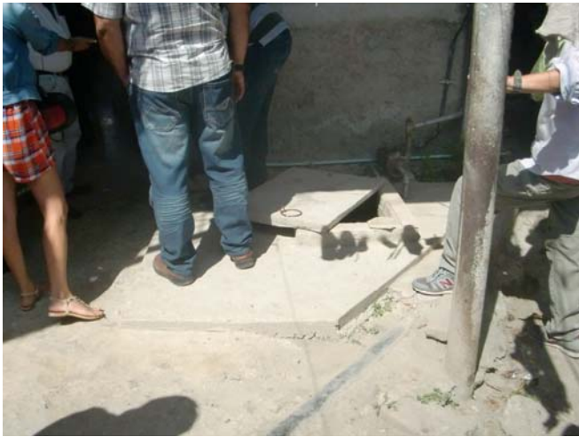
写真1 家庭の配水タンク
