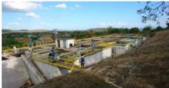
No.9 Alcides Pino浄水場 1957年に建設された浄水場。処理能力は、184L/s。
