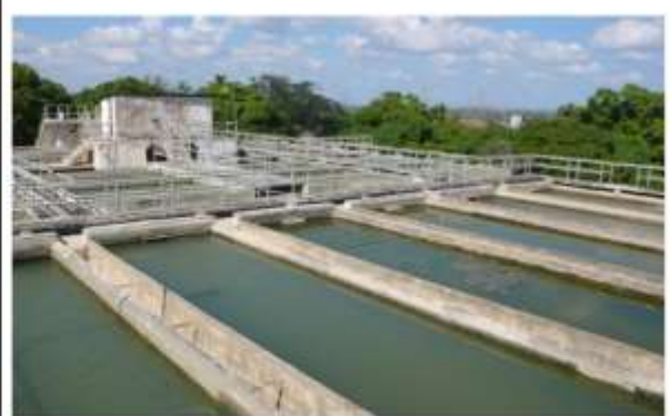
No.12 Pedernales浄水場 1980年に建設された浄水場。処理能力は、315L/s。
