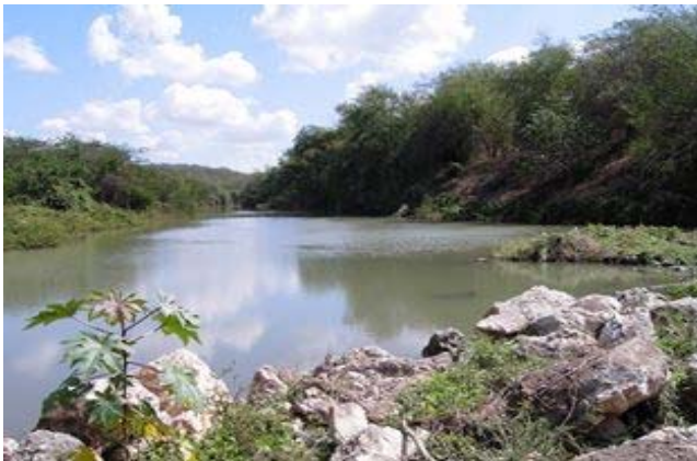
Cauto川 取水施設付近の流況
