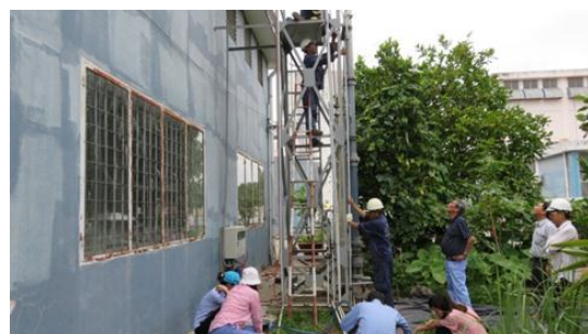
パイロットプラント再組立
