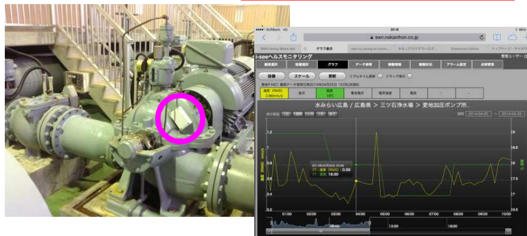
状態センサーによる 機器状態監視システム
