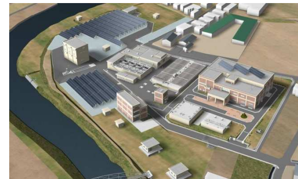
例：春日那珂川水道企業団における東隈浄水場施設改良事業(DB)
