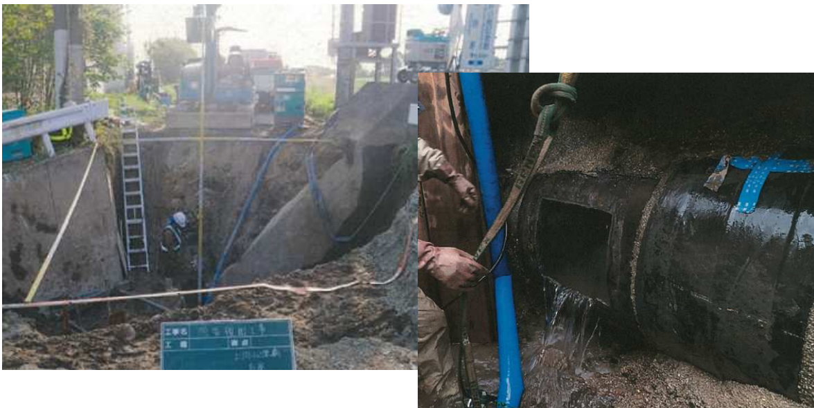
写真 4.2.4 応急復旧工事の状況
