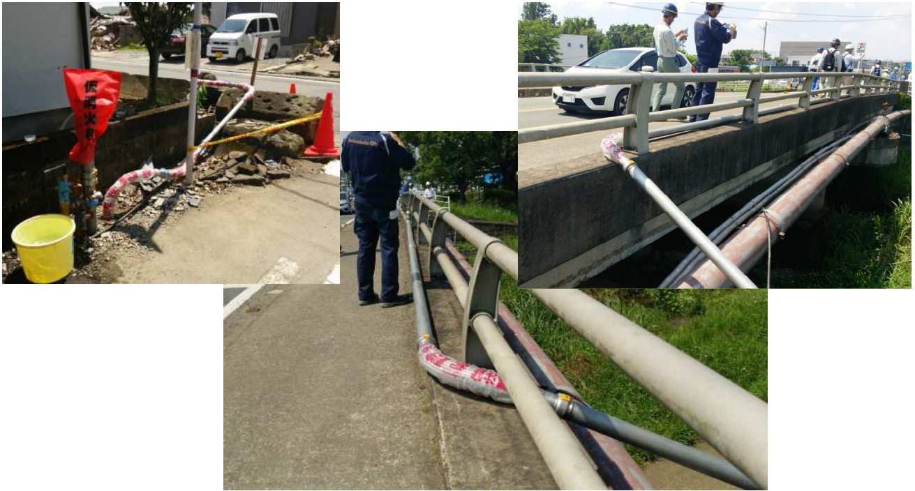
写真 4.2.3 仮設配管による応急復旧状況
