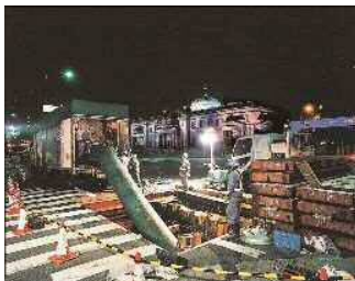
管更生工事（パルテム HL 工法）
