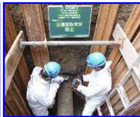
埋設環境調査
