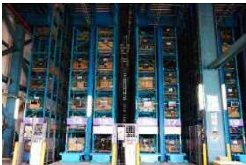
自動立体倉庫
