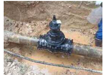
緊急不断水工事
