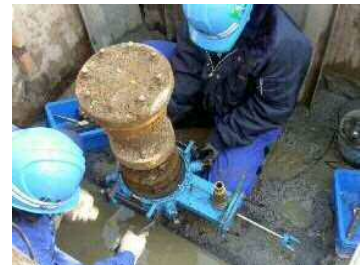
補修弁取替工法
