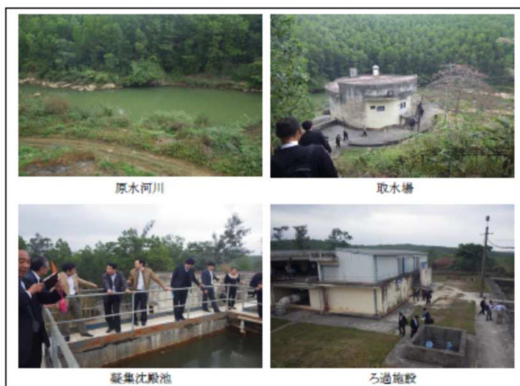
図 5-5 ドンホ浄水場における現地踏査の様子
