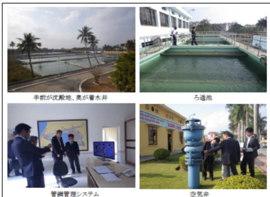
図 5-3 アンズオン浄水場における現地踏査の様子
