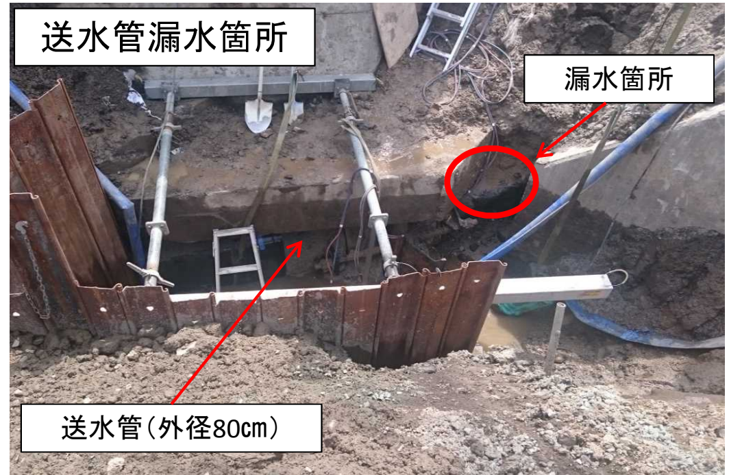
送水管漏水状況
