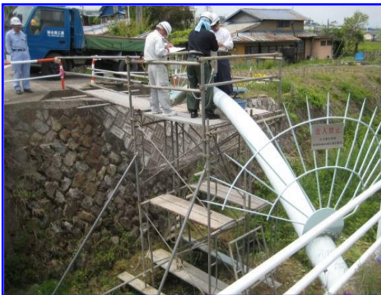
水管橋点検(弁栓類点検)
