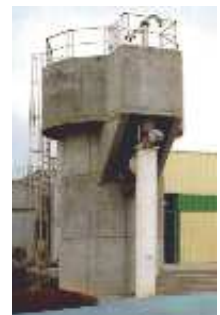
Uチューブオゾン接触装置
