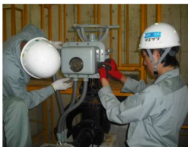
バルブの点検調査
