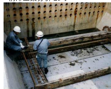
沈澱池機械の点検調査
