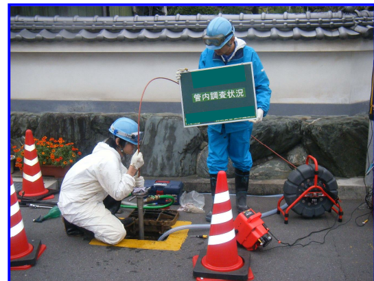
管内調査(不断水管内カメラ調査)
