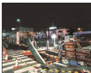
管更生工事（パルテム HL 工法）
