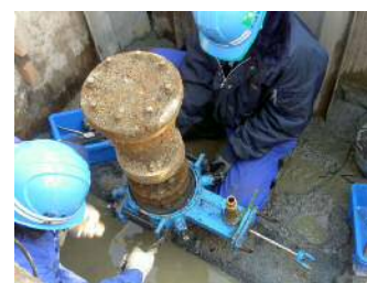
補修弁取替工法
