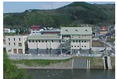
二戸市浄水場
