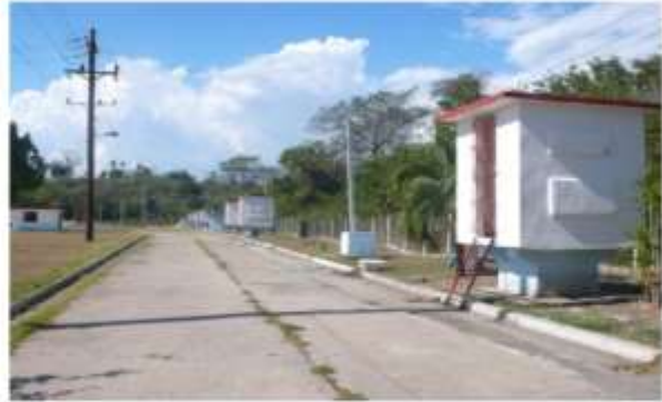
No.14 San Juan井戸群 INRHで管理している井戸施設。塩素を注入して、配水している。
