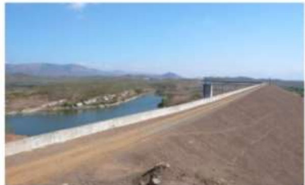
No.10 Paradaダム 1985年に建設されたアースフィルダム。Parada浄水場へ導水している。
