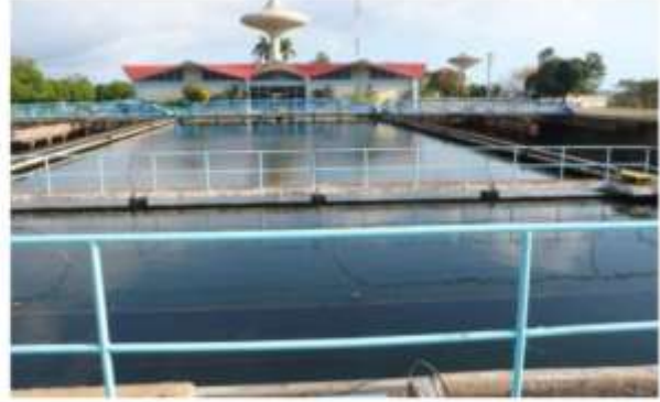
No.8 Quintero I 浄水場 1963年に建設されたアメリカ式の浄水場。処理能力は、1,500L/s。
