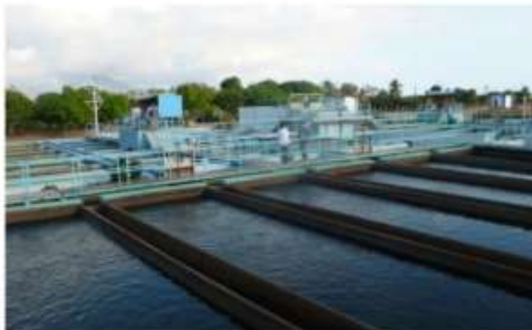
No.9 Quintero II 浄水場 1981年に建設されたフランス式(デグレモン)の浄水場。処理能力は、900L/s。
