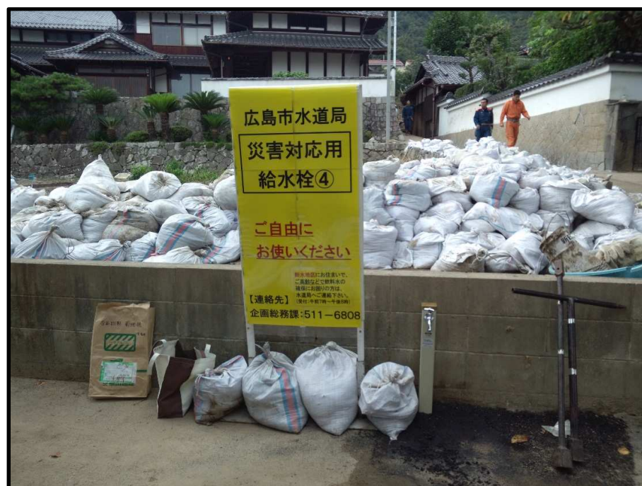
【配水管から分水し立水栓を設置したもの】
