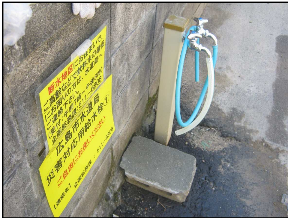
【配水管から分水し道路際に立水栓を設置】
