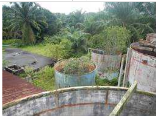
遺棄された以前の浄水場
