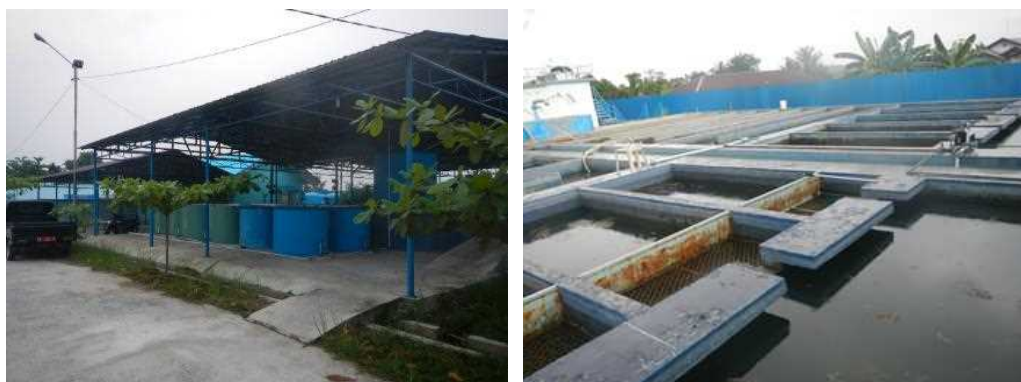
図 12 Sudirman 浄水場の沈殿地
