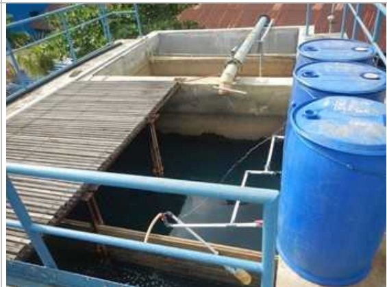
Pramuka 浄水場の薬品注入箇所
