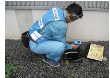
メーター毎の漏水調査
