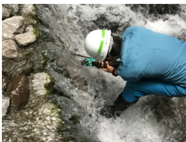
補助水源の導水管詰まり除去作業
