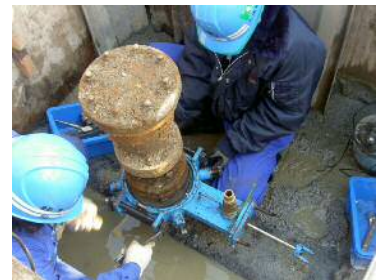
補修弁取替工法
