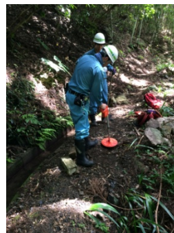
金属探知機を使用した 導水管のバルブ位置調査
