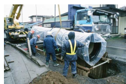
導水管布設状況φ1000(S形)
