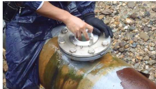
空気弁分解点検
