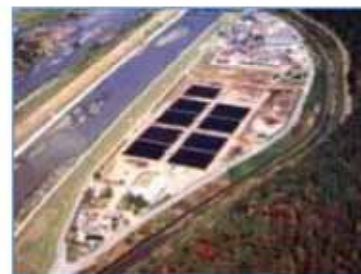
出原浄水場全景
