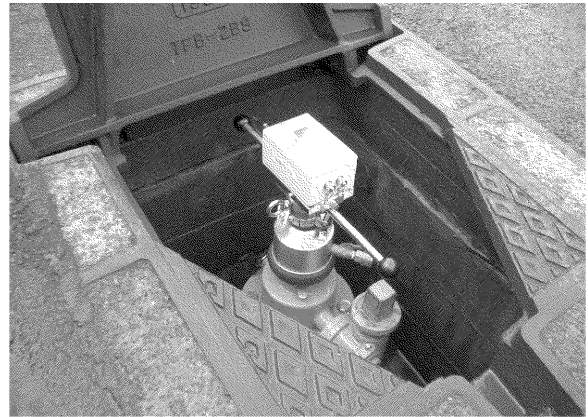
図-9.2.8 挿入式流量計
