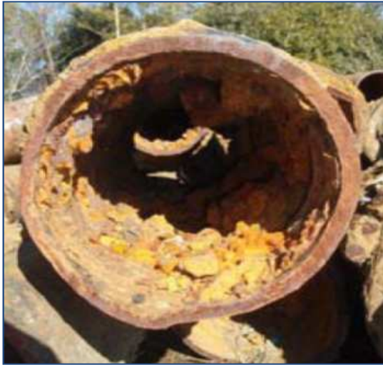
経年化による内面腐食
